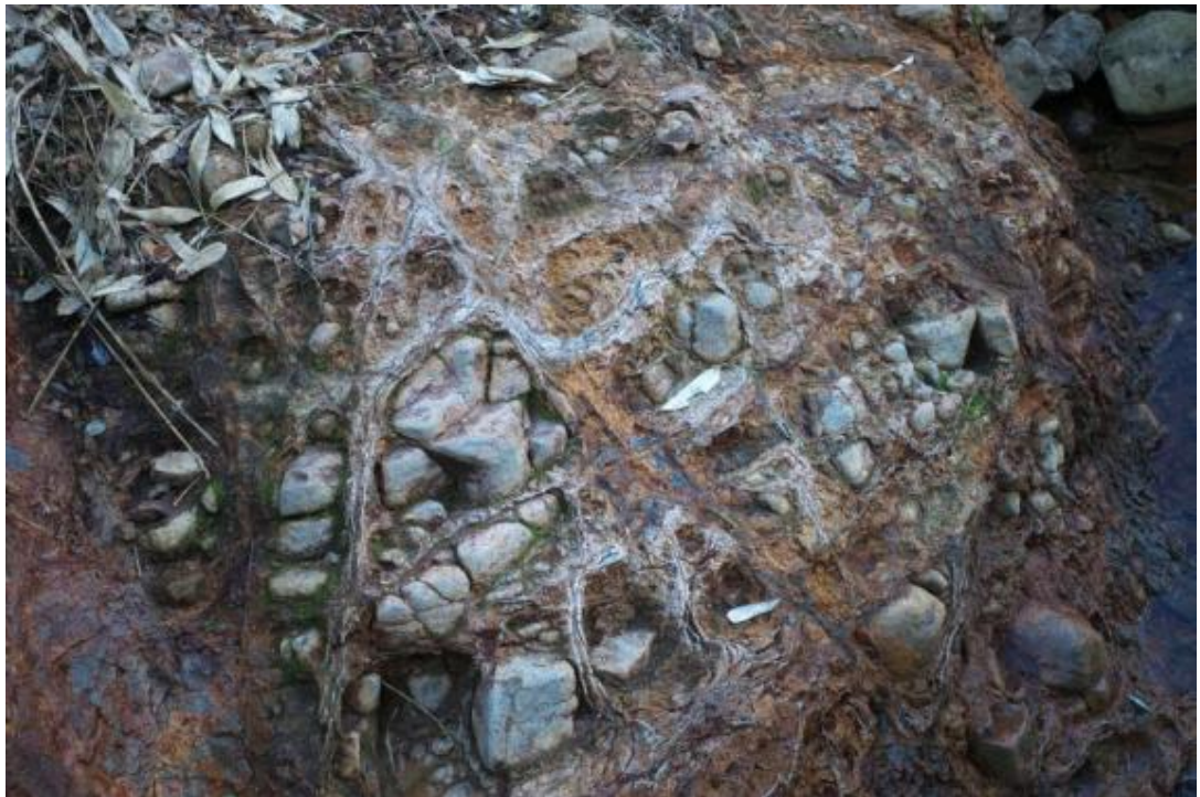
7月21日 珍しい岩。いかにも脆そう。この流域は土砂崩れが多いわけだ。
